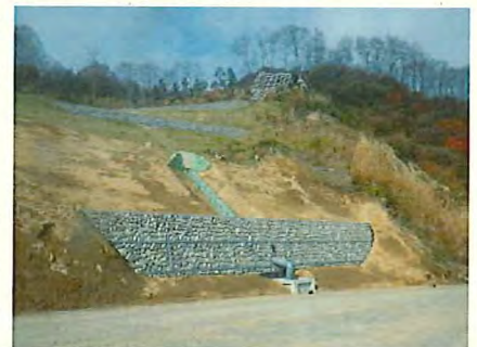
図206 長野県北部地震の復旧工事跡 2015. 11. 07
