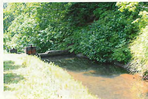
図117 水路の末端 砂防堰堤と水門 2015.08.09
