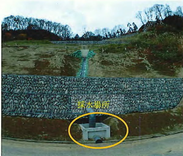
Fig.-18、林道（寺石～菅沼線）脇のトレンチ 分水嶺となっている尾根からは、50~60m程の 標高差である。採水は、この距離間から出る浸出 水である。（2015-11-04 撮影）
